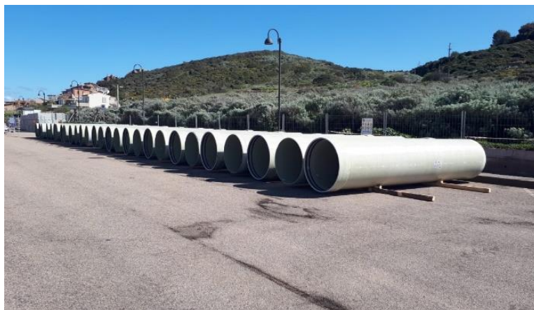
Figura 9 - Arrivo delle tubazioni in cantiere e marchio univoco per tracciamento BIM
