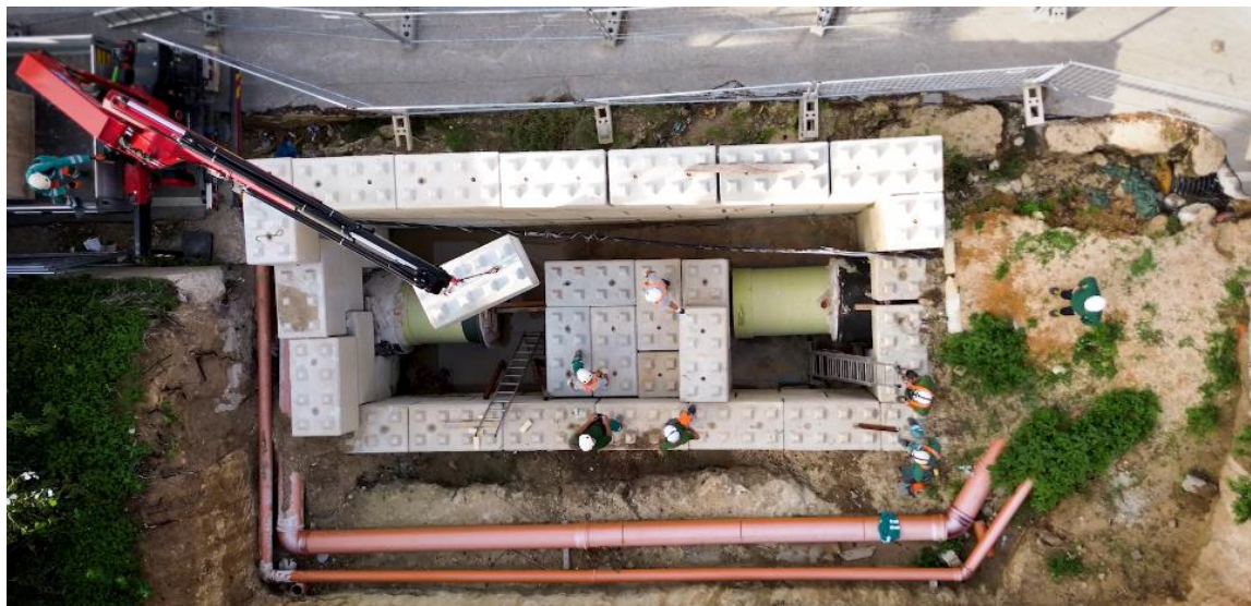
Figura 14 – Realizzazione di una camera di inserimento tramite Legoblock
